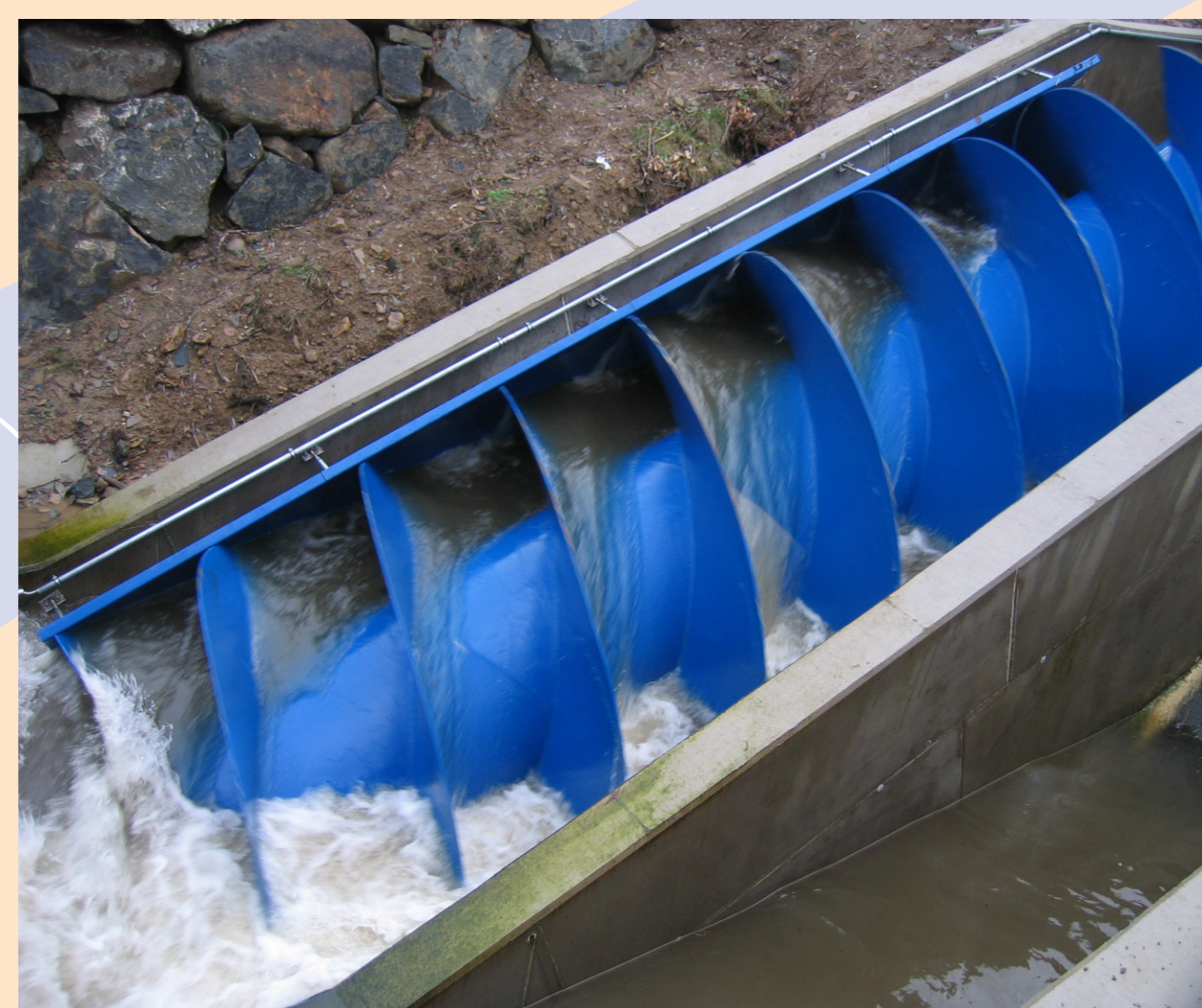
Wasserkraftschnecke im Betrieb
