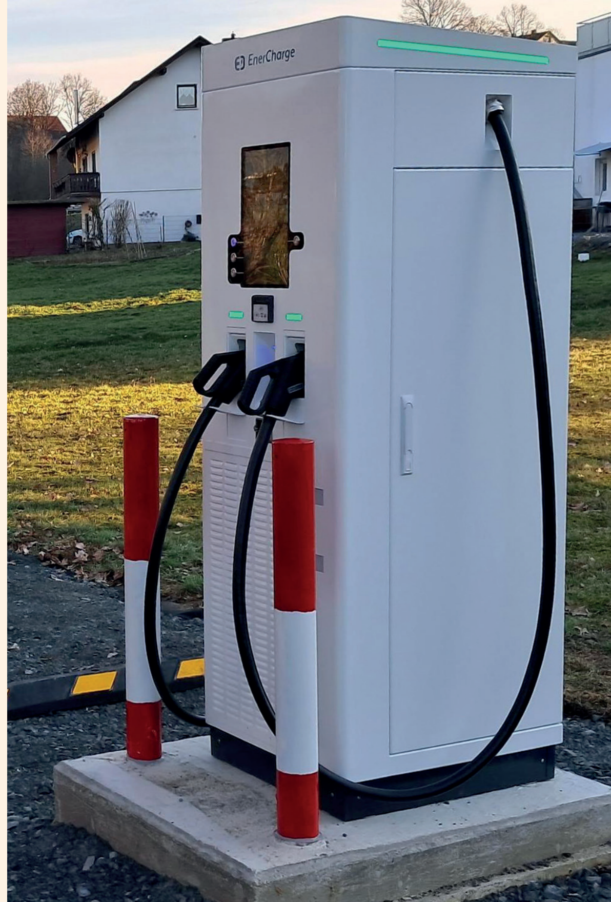
Schnellladesäule mit Bedienterminal und Kartenlesegerät
