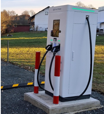
Schnellladepunkte CCS und Bezahlterminal
