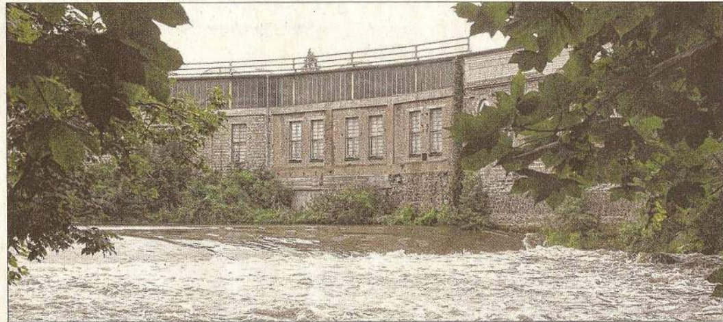
Auf der Uferseite – gegenüber der Gebäude von Buderus – soll das Wasserkraftwerk sowie ein kombinierter Fischaufstiegs- und Kanupass entstehen. (Fotos: khn)
