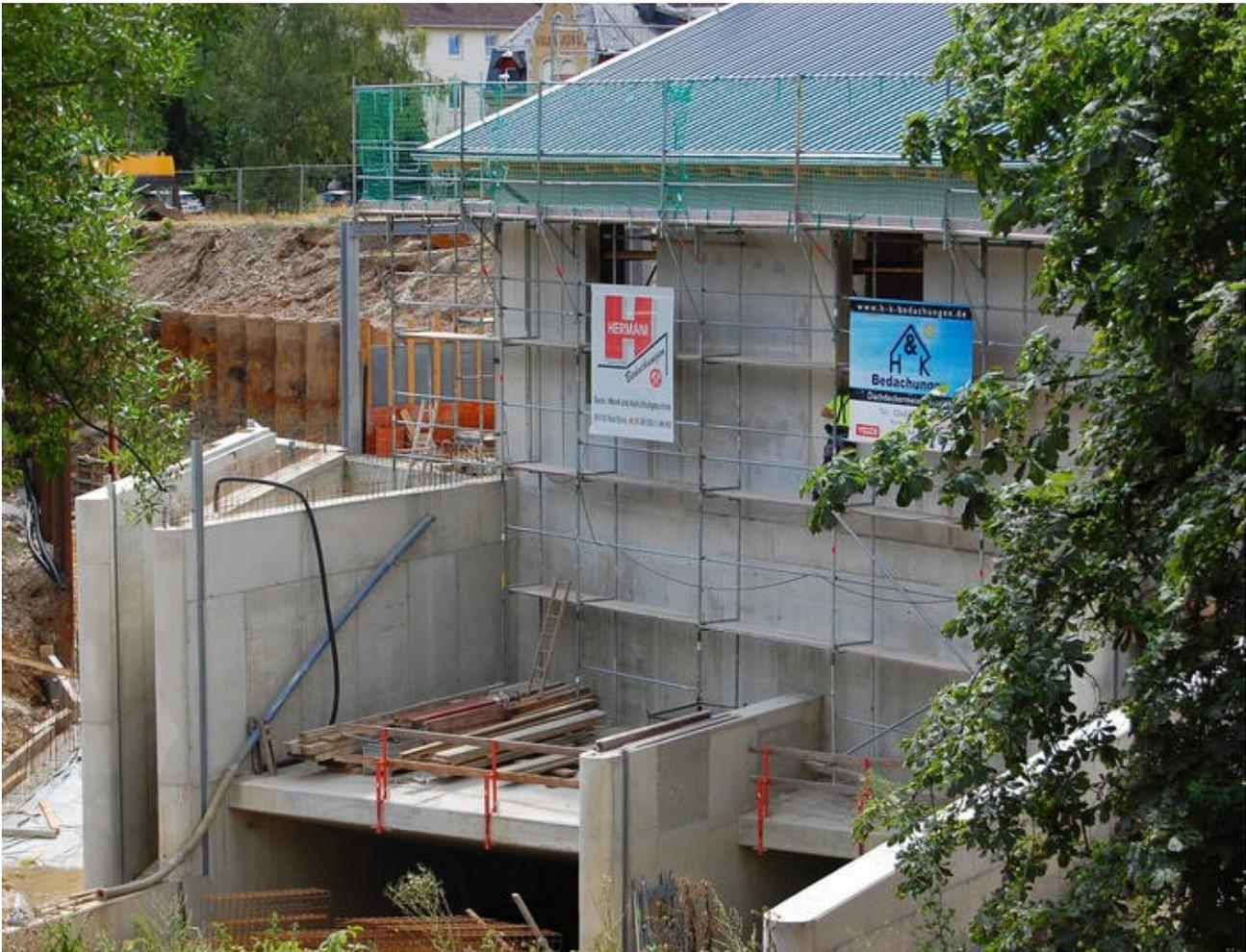
Der mit großem Aufwand gebaute Auf- und Abstieg der Fische fällt – neben dem Turbinenhaus des Wasserkraftwerks am Fuße der Remybrücke – direkt ins Auge.
