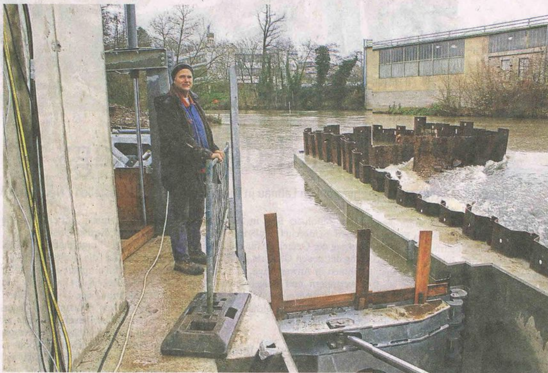
Fertig: Ronald Steinhoff am schon gefluteten Zulauf beim Turbinenhaus des neuen Wasserkraftwerks. Draußen vor der Spundwand (rechts) tost die durch Regenwetter anschwellende Lahn vorbei. Foto: Emmerich
