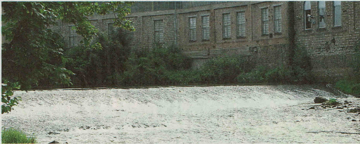
Das Buderus-Wehr in Lollar: Hier soll bald das Wasserkraftwerk entstehen.
