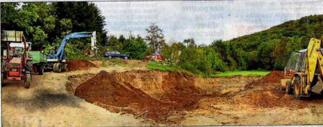
Für den Bau des Wasserkraftwerks muss einige Meter neben dem Lauf der Lahn eine große Grube ausgehoben werden, in die die Turbine eingelassen wird.
