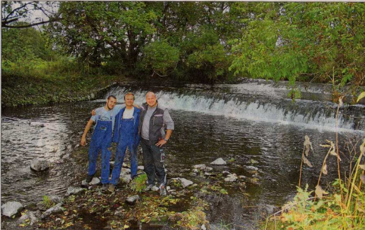
Marcel Freiling (v. l.), Ronald Steinhoff und Meik Tillmann bauen am Dammhammer bei Elmshausen zusammen ein Wasserkraftwerk. (Fotos: Valentin)
