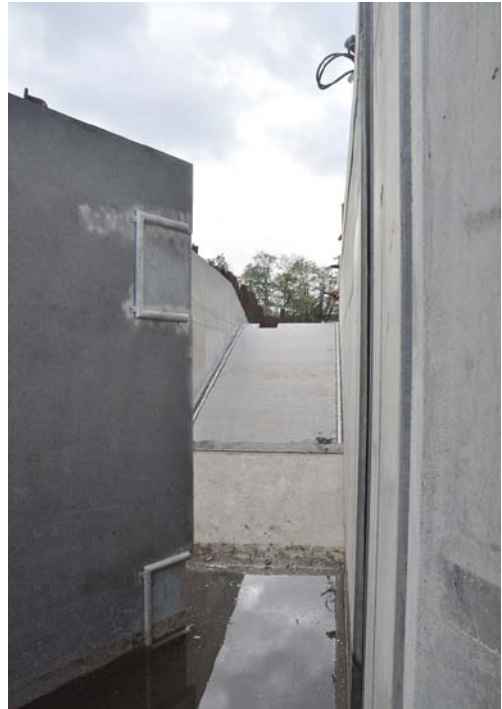
Abb. 4: Die Stemmtür mit verschlossenen Abstiegsöffnungen und Bremswehr
