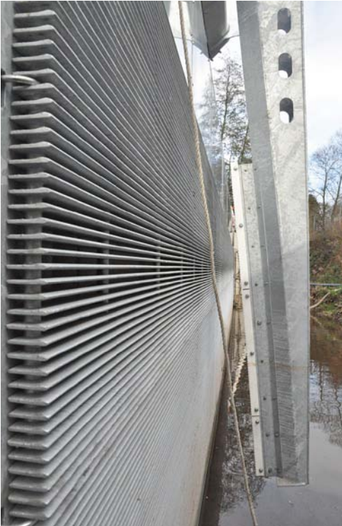
Abb. 5: Rechen mit Rechenreinigerarm ohne Bürsten zur Sohlkantenreinigung
