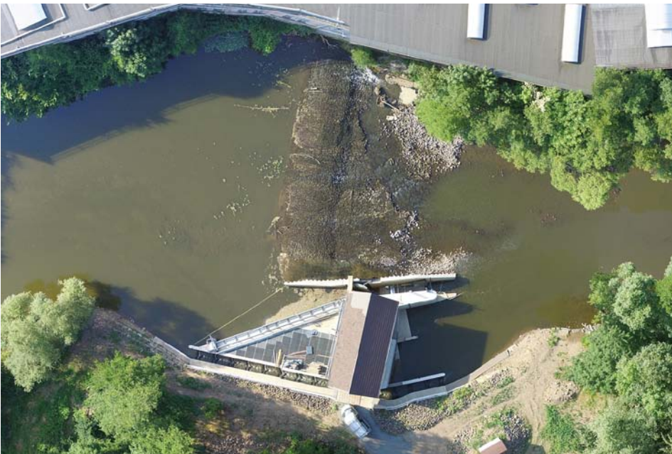
Abb. 8: Blick von oben auf die Wasserkraftanlage Lollar alle Abbildungen: Steinhoff/Friedrich
