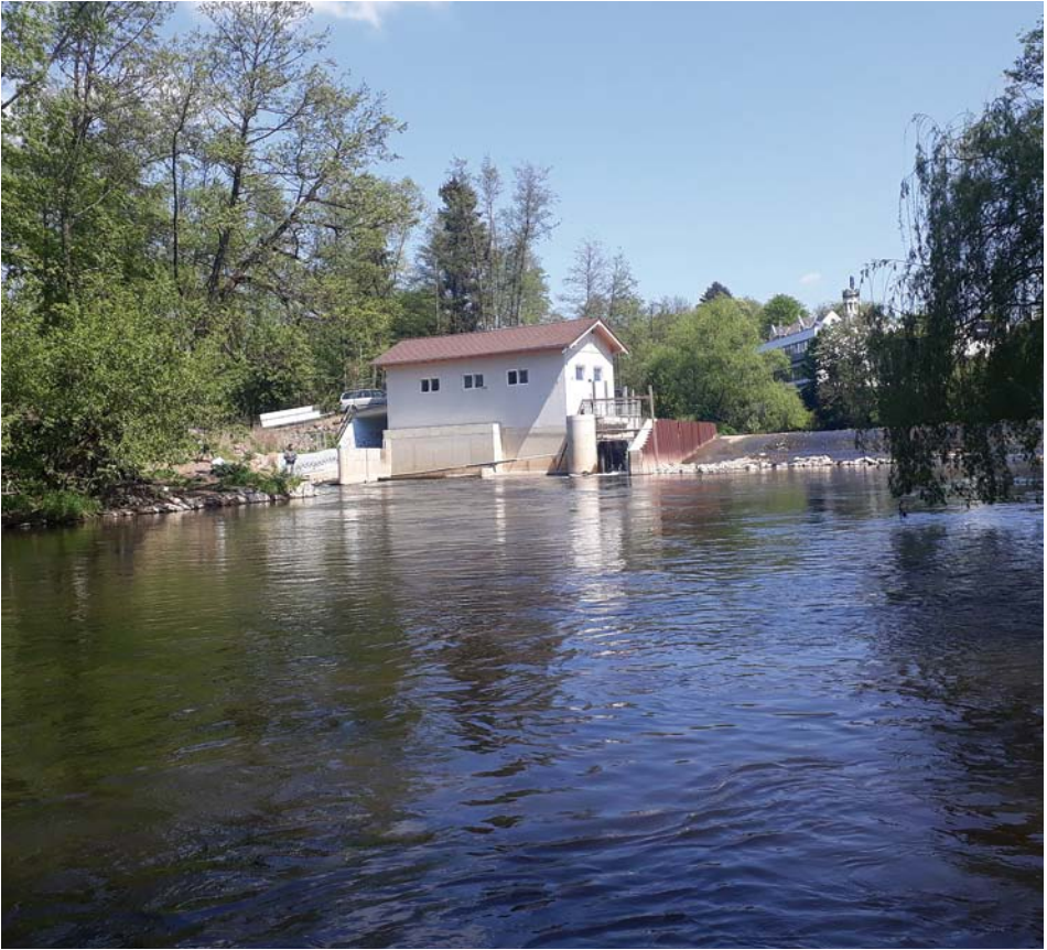
Abb. 2: Das Kraftwerk vom Unterwasser aus gesehen
