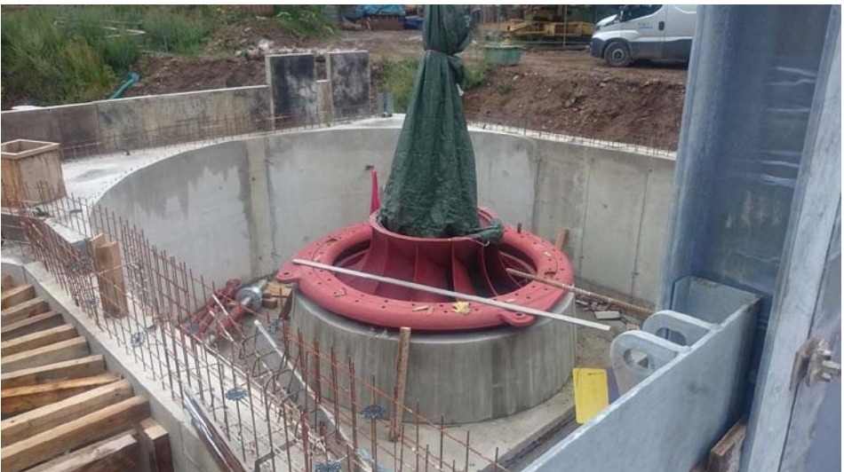
Abb. 3: Einlaufkammer der Turbine 1 im Bau
