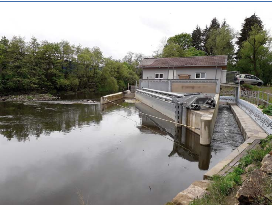
Abb. 1: Das Kraftwerk an dem Buderuswehr in Lollar an der Lahn vom Oberwasser aus gesehen
