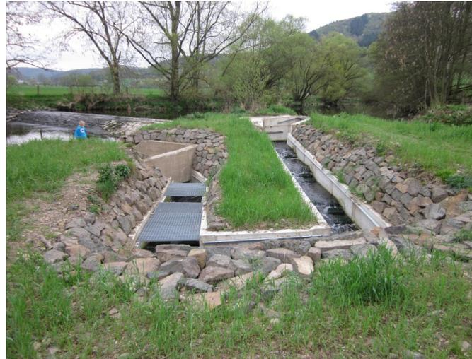
Darüber hinaus wurde das Mutterbett der Lahn durch Querriegel strukturiert und mit einer Niedrigwasserrinne ausgestattet, um den Fischen den Weg zum Fischpass zu erleichtern.
