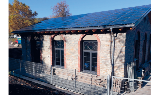
Krafthaus mit Photovoltaikanlage
