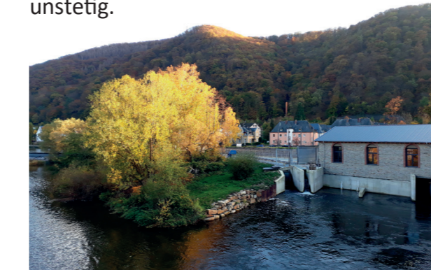
Nach Fertigstellung der Fassade
